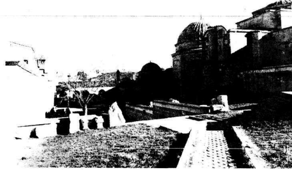
Battalgazi Külliyesi, avlu, batıdan bakış
