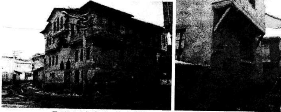
Fotoğraf 2-3. Cephe yüzeyindeki pencereleri kapatılmış konutlar
