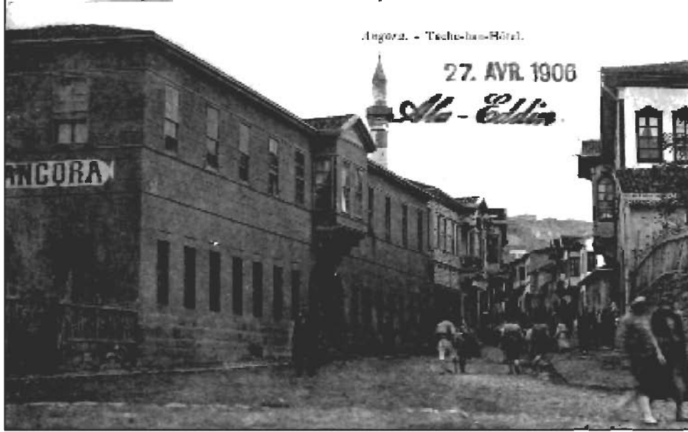
(Resim 6) Taşhan, Hotel d'Angora, Karaođlan Çarşısı. Demiryolunun Ankara'ya ulaşması sonucunda deđişen ticari yapı 1890'ların sonunda Karaođlan Çarşısı'nı şehrin cazibe merkezi yapmıştır. Bu dönemde açılan Taşhan ve önündeki meydan şehrin yeni merkezi olmuştur. Dört köşe olan hanın iç avlusunda hayvanların barınađı vardı. Hanın bir bölümünde yer alan Hotel d'Angora, dönemin kalınabilir tek yeriydi.
