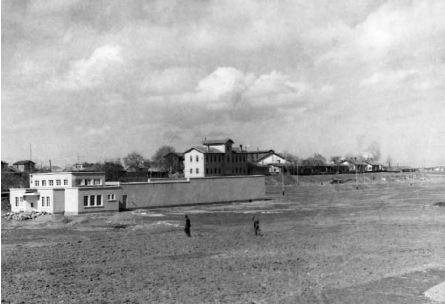
Atış Poligobu binasının inşaatı bitmiş, arkada İstasyon'la ilgili binalar görülmekte. (BYEGM Arşivinden)
